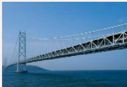
明石海峡大橋
