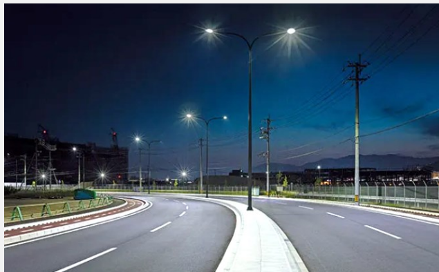
(例)道路照明のLED化
