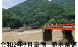
令和2年7月豪雨 熊本県道
