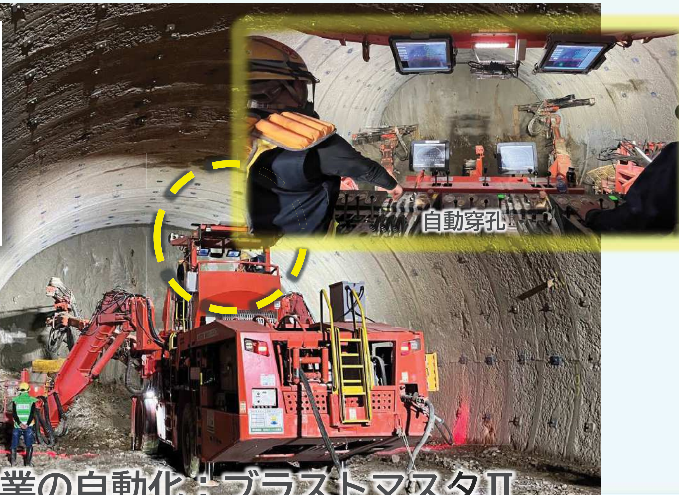
発破パターン、穿孔順序の自動設計
